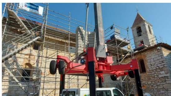
Photo 2 : Chantier de rénovation
